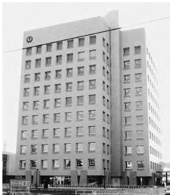
八戸市庁舎別館／鉄骨工事（平成9年度竣工）
