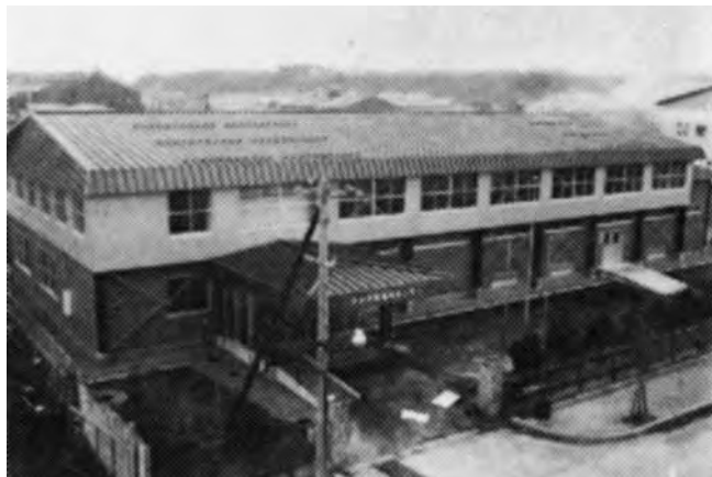
完成した八戸市共同福祉センター（通称八戸工業会館）
