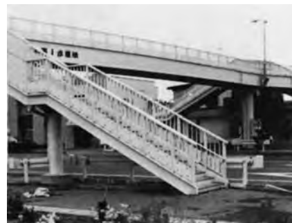
八戸鉄工協同組合施工の河原木第1歩道橋
