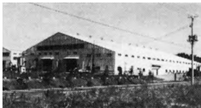
完成した桔梗野金属工業協業組合の共同工場
