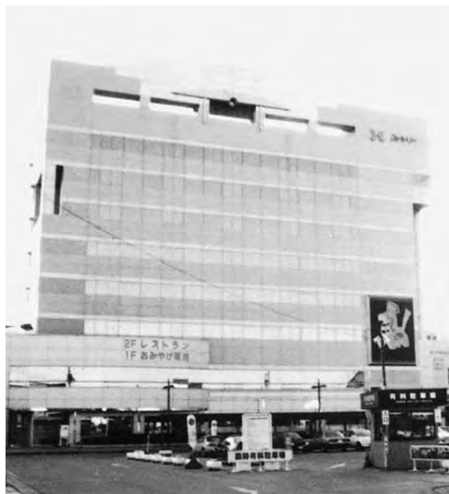
ユートリー／鉄骨工事 （平成3年度竣工／助八戸地域地場産業振興センター）
