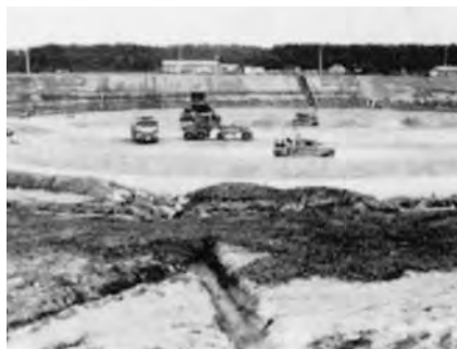
むつ小川原石油国家備蓄基地 タンク基礎工事
