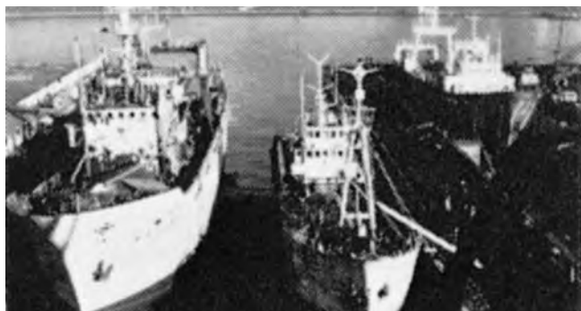
完成した北日本造船ドック
