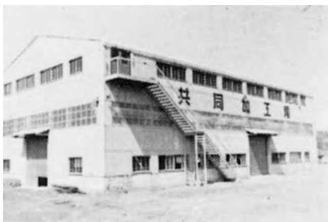
八戸鉄工団地協同組合共同加工工場
