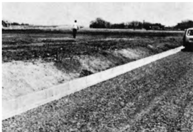
桔梗野金属工業協業組合共同工場建設予定地
