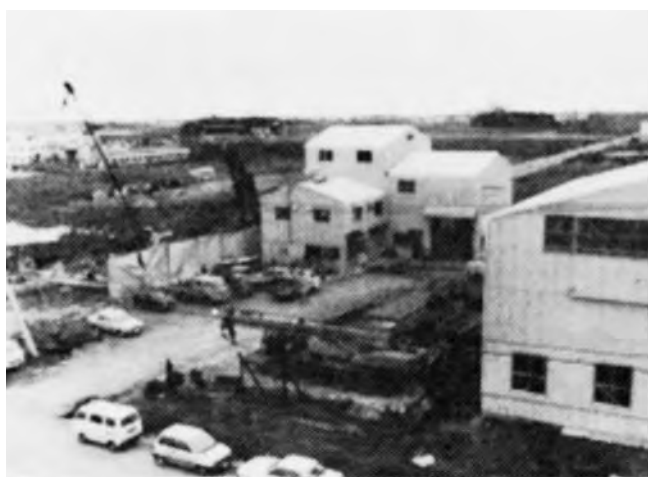
建設中の八戸金属工業センター（昭和56年）
