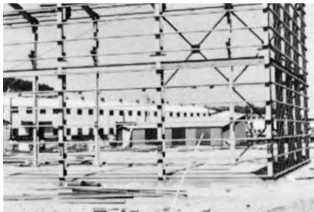
建設工事中の八戸鉄工団地
