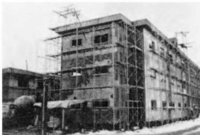
建設中のみどり寮
