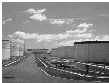
むつ小川原石油備蓄タンク
