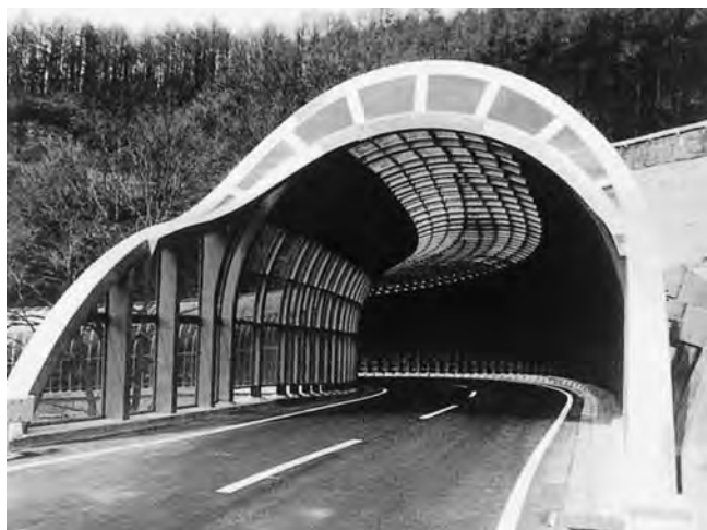
国道104号 田子町 スノー・シェルター
