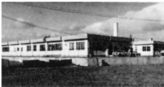
完成した青森県機械金属試験所
