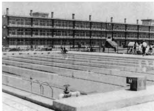
第二中プール工事
