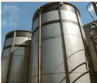
廃LLC他、保管タンク
