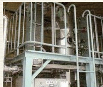
廃LLC濃縮処理施設
