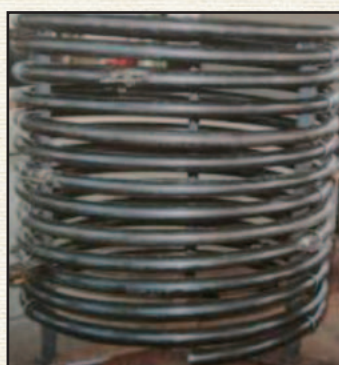
パイプ曲げ加工
