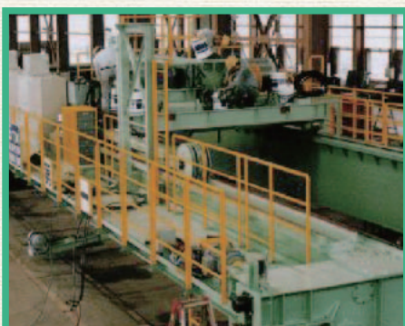
3.5t×18.8m 旋回吊ビーム付天井クレーン
