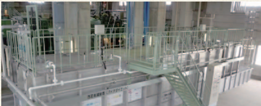
登別市若山浄化センター殿汚泥削減装置
