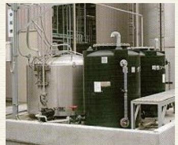
廃酸、廃アルカリ中和処理施設
