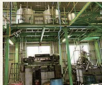
油水分離処理施設
