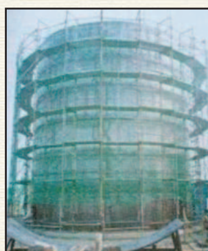
タンク据付工事
