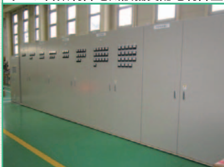
ポンプ台数制御電気設備受配電制御盤
