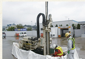
注入井戸設置工程
