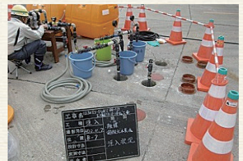
浄化剤注入工程
